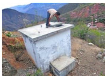
Reservorio Antapita Suyubamba
