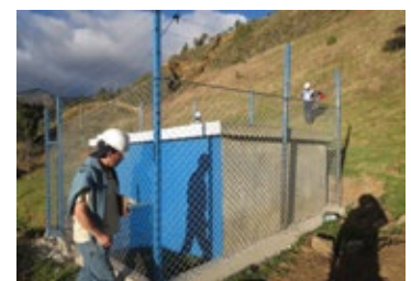
Reservorio Cedro - Socorro
